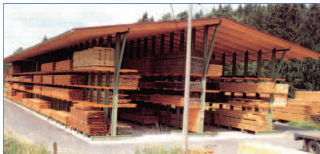
Rys. 3. Budowla magazynowa półotwarta – wiata nieosłonięta. Źródło: Materiały prospektowe.
