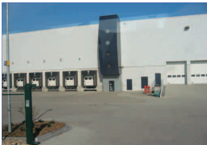
Rys. 7. Budowla magazynowa zamknięta – budynek magazynowy parterowy. Źródło: Fot. własna.
