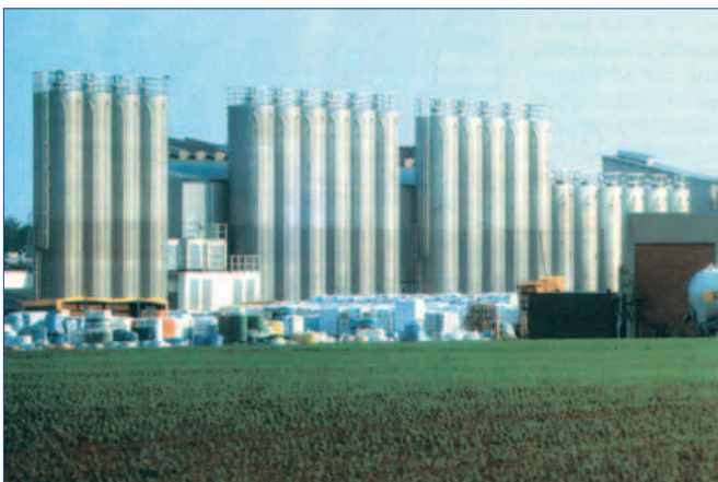
Rys. 5. Budowla magazynowa zamknięta – silosy. Źródło: Materiały prospektowe.
