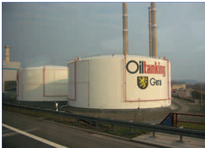
Rys. 4. Budowla magazynowa zamknięta – zbiornik zamknięty naziemny. Źródło: Fot. własna.
